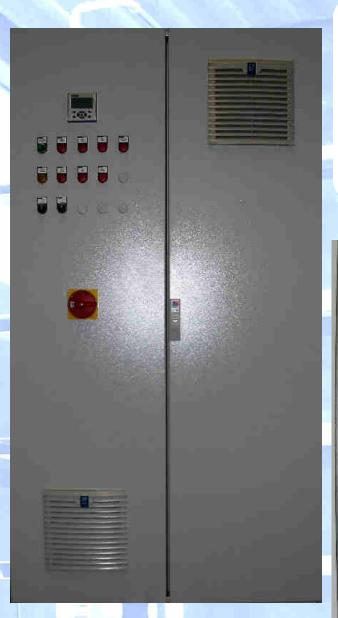
Projekt: MSR-Schaltschrank einer VE-Wasseraufbereitungsanlage für
